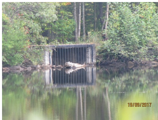
Photo 2 – Barrage à Monette
